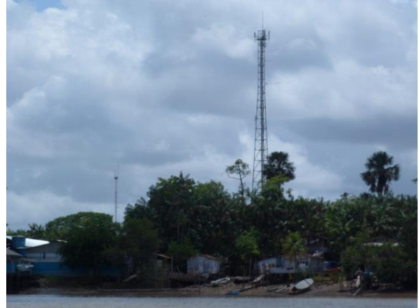
Figura 10: Antena de telefonia móvel na Vila
