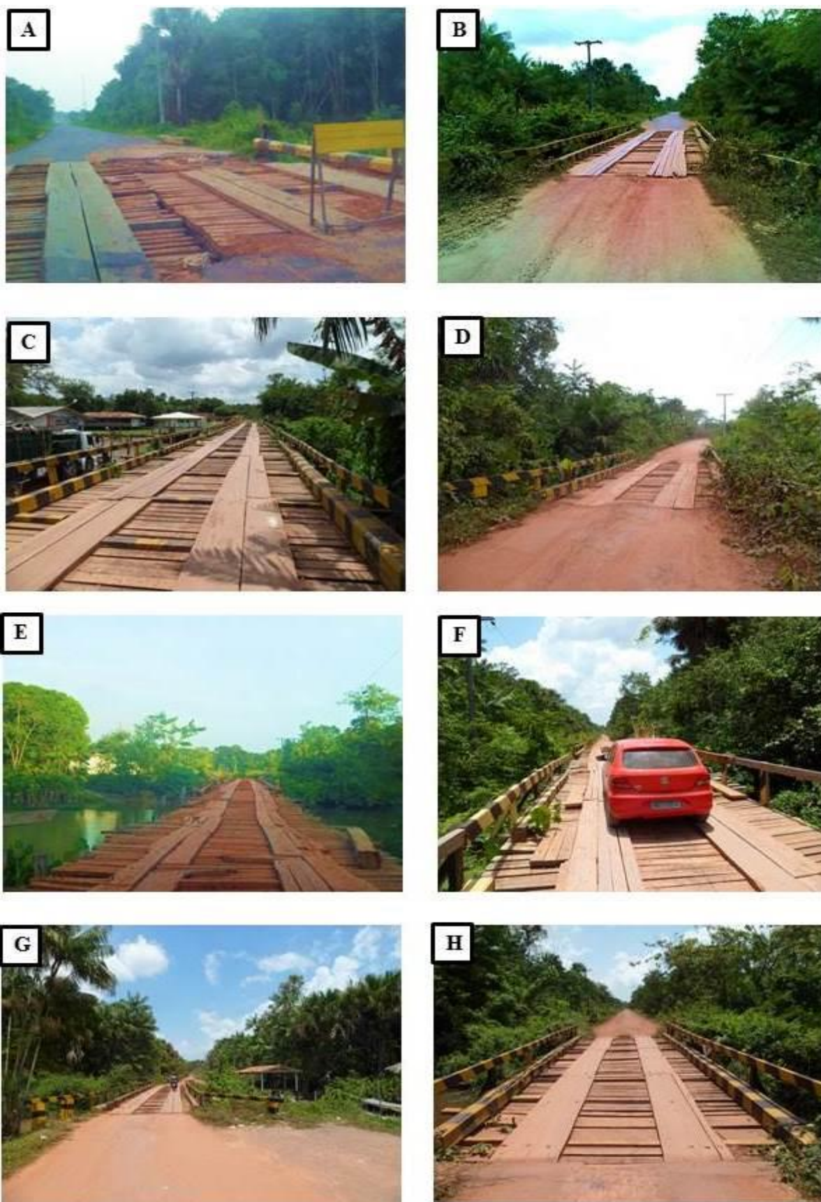
Figura 23: Estado de conservação das pontes da PA 407
