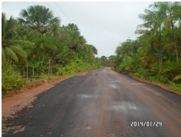
Figura 21: Início na PA 407 com capeamento asfáltico recente
